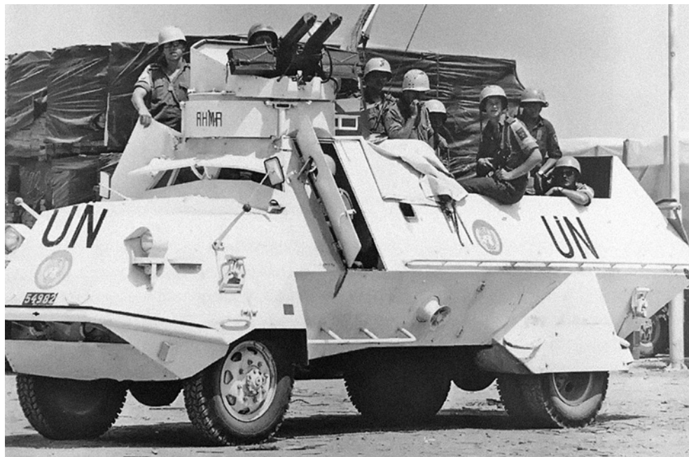
Transporter KP szwedzkiego kontyngentu wojsk ONZ w Famaguście na Cyprze. Widoczna obrotnica z dwoma przeciwlotniczymi karabinami maszynowymi. (Försvarsstabens bildarkiv, Krigsarkivet)
